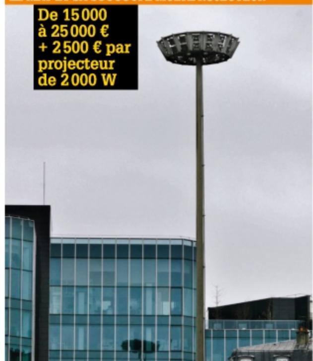
Planter un grand poteau de 15 à 25 mètres avec une puissante armoire électrique représente de sacrés frais ! Et il reste encore à payer la mise en place de chaque projecteur de 2 000 W. Et là, ça douille ! Tout compris, ce type d'éclairage peut atteindre 50 000 €.
